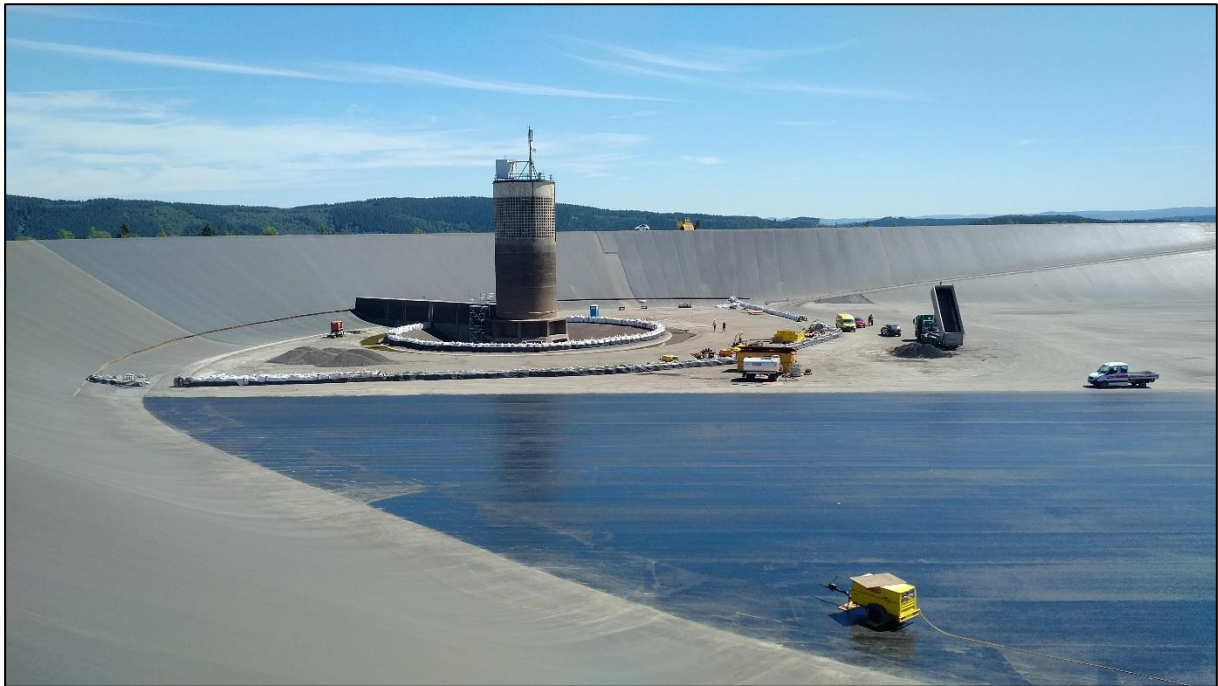
Abbildung 3-2: Oberbecken PSW Rönkhausen – Sanierung 2018
