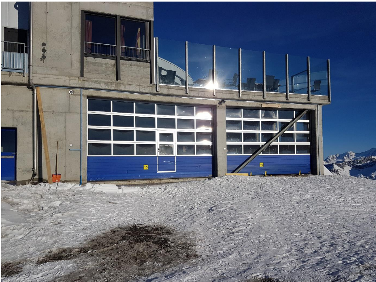
Abbildung 5.1: Rückwärtiger Bereich der Gipfelstation
