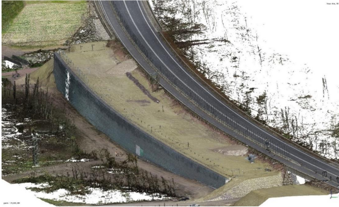
Abbildung 3-9: 3D-Modell Bestandsbauwerk aus UAV-Photogrammetrie.
