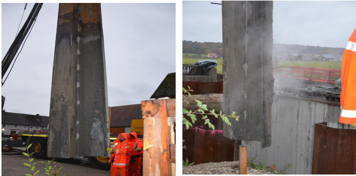
Abbildung 2-30: Erschütterungen durch Einbringen / Ziehen von Spundwänden
