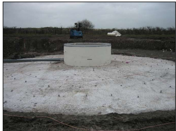
Abbildungen 3-2a und 3-2b: Blick auf die zur Setzungskorrektur installierten Leerrohre innerhalb des WEA-Fundamentes.
