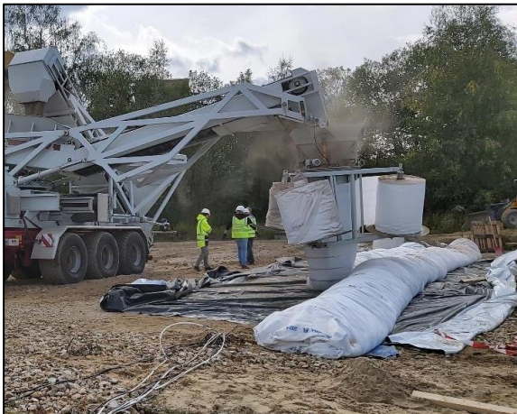
Abbildung 1-1: Herstellung eines Testdeichs
