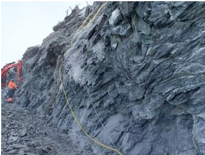
Abbildung 4.1: Strongly foliated serpentinite at the excavation front. (b) Typical superficial undulated rock flakes. Stark blättriger Serpentinitt an der Ausbruchfront. Typische oberflächliche gewellte Gesteinsschuppen.
