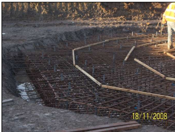
Abbildungen 3-2a und 3-2b: Blick auf die zur Setzungskorrektur installierten Leerrohre innerhalb des WEA-Fundamentes.
