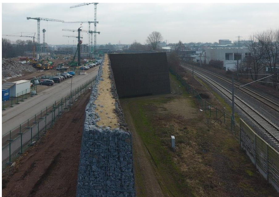
Abbildung 3-13: Ansicht / Foto Bauwerk.
