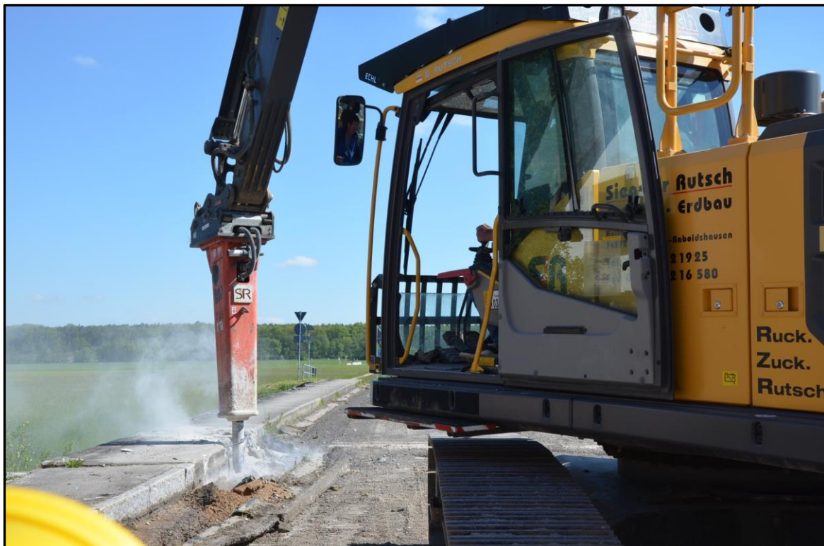
Abbildung 2-28: Erschütterungen durch Meißelarbeiten
