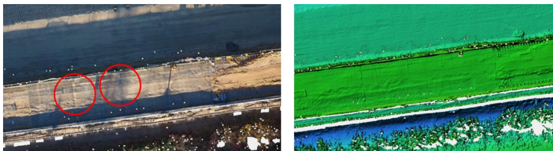
Abbildung 3-7: Verlegung Geogitter / Höhenabweichungen.
